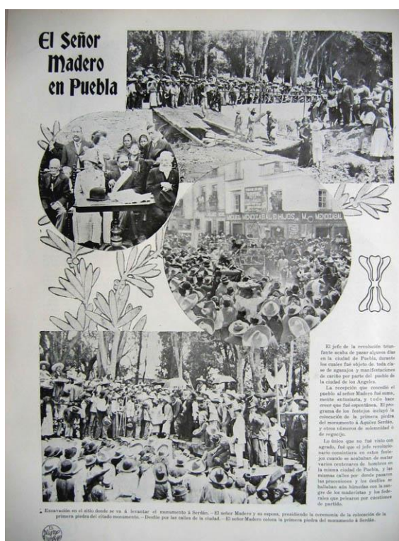
Figure 68. El Mundo Ilustrado , 23 juillet 1911. « Excavation du lieu où sera érigé le monument à Serdán – Monsieur Madero et sa femme, présidant la cérémonie de pose de la première pierre dudit monument – Défilé dans les rues de la ville – Monsieur Madero pose la première pierre du monument à Serdán »
