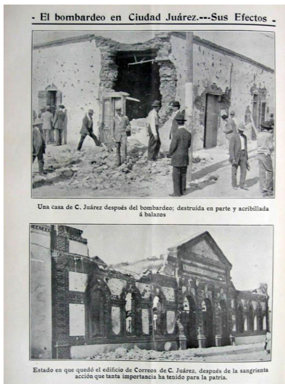
Figure 7. La Semana Ilustrada , 26 mai 1911. « Une maison de Ciudad Juárez après le bombardement, en partie détruite et criblée de balles – État du bâtiment de la Poste de Ciudad Juárez, après les événements sanglants qui ont eu tellement d'importance pour la patrie »
