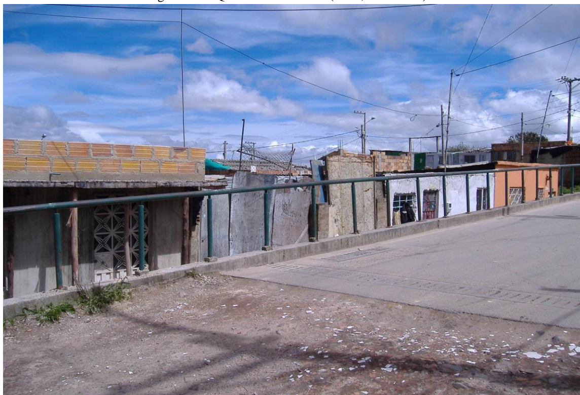
Photo 18 : Même secteur suite aux travaux sur la voie. On peut observer l'avancement lent des' travaux tant dans la maison de gauche pour la construction de l'étage, que dans la maison de droite' pour l'amélioration de la toiture. (KFW, 2006)'
