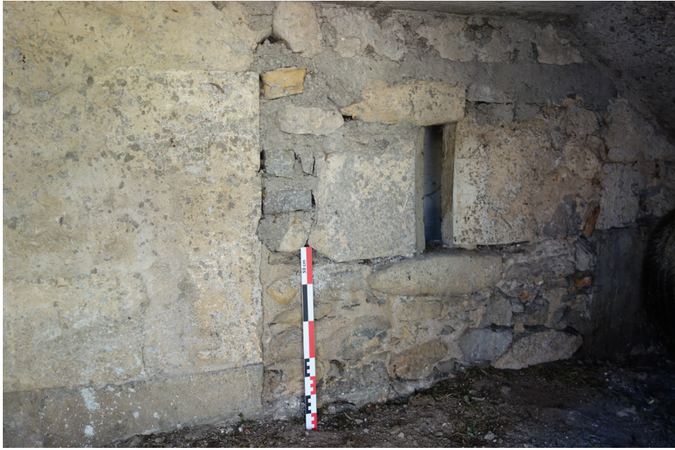
Fig. 12 - Ouverture dans l'aile nord (OUV 2060) vue depuis l'extérieur.
