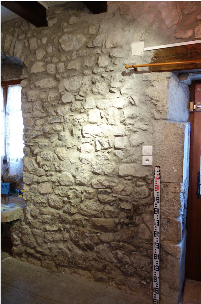
Fig. 36 - MUR 2061, façade intérieure (accueil du musée de l'abbaye).
