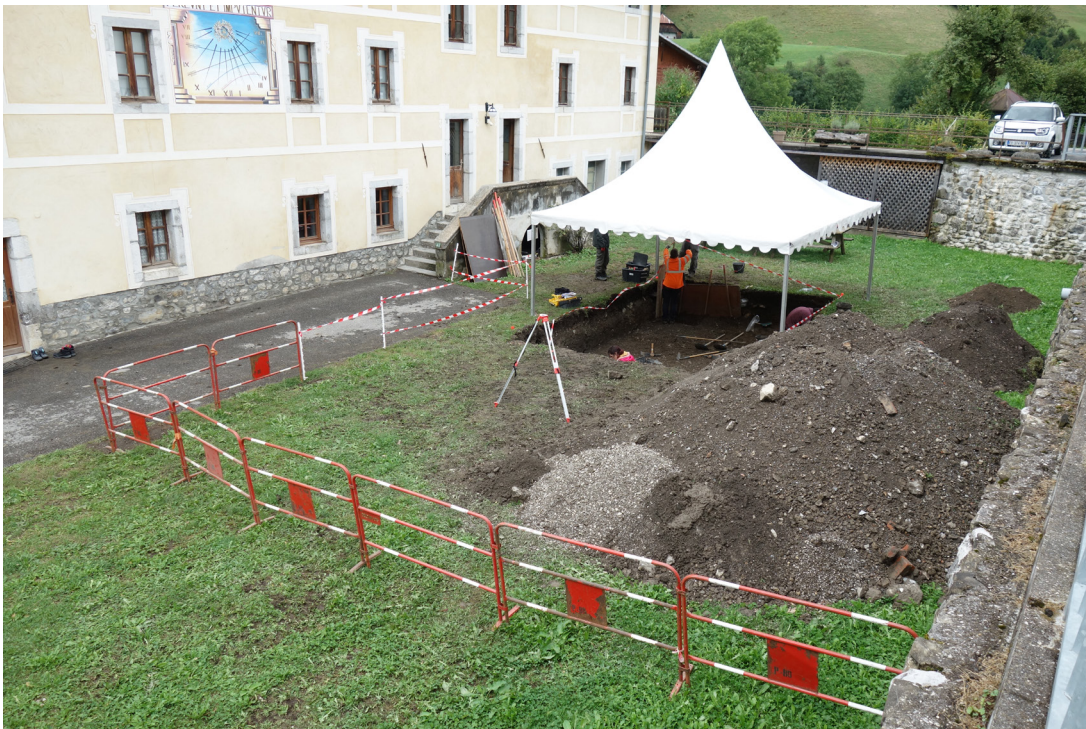
Fig. 17 - Sécurisation du chantier par des barrières.
