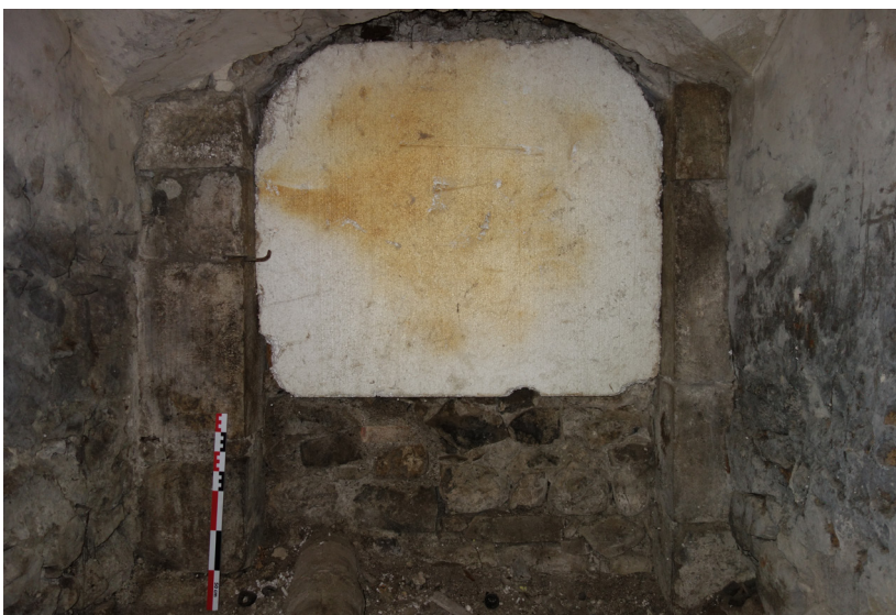
Fig. 11 - Ouverture dans l'aile nord (OUV 2060) vue depuis l'intérieur.
