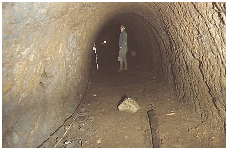
Grande galerie rectiligne du souterrain n°1 de Montbrun
