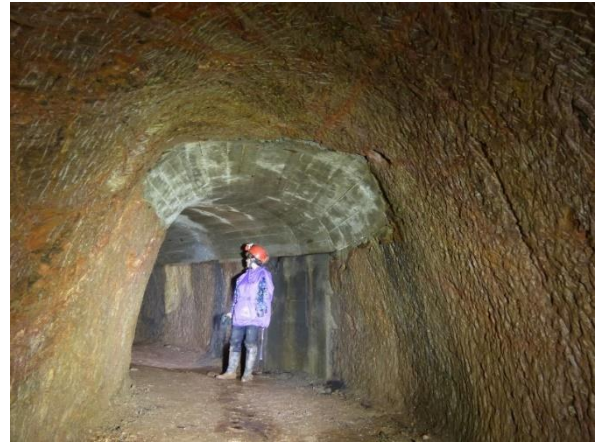
La grande galerie nord et la voûte restaurée.
