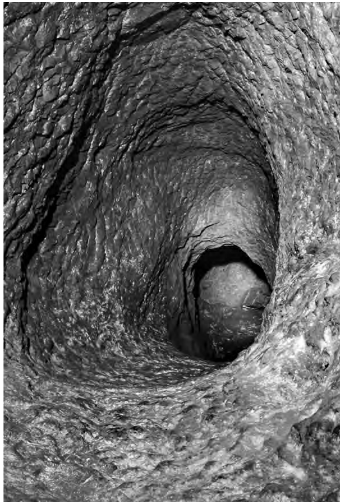
Fig. 8 Galería de comunicación o enlace hallada en el sector este de la mina de la Rambla del Abenque.
