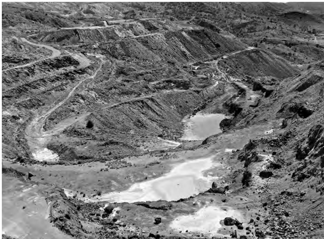
Fig. 2 Estado actual de la corta San José en Portmán.
