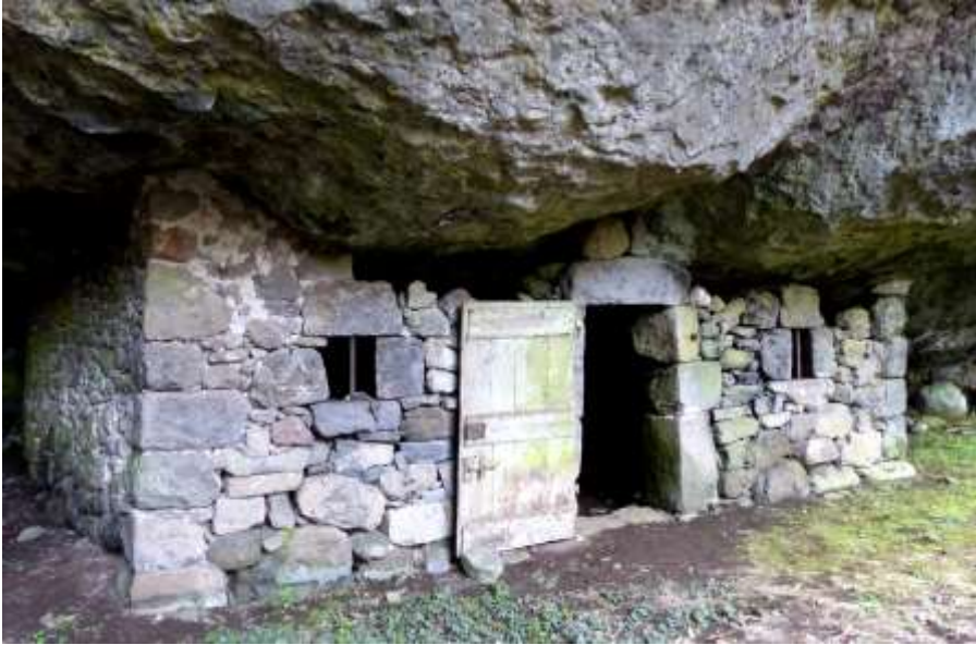
Fig. 22 : Construction semi-troglodytique du site la cascade de Lavergne, Tournemire
