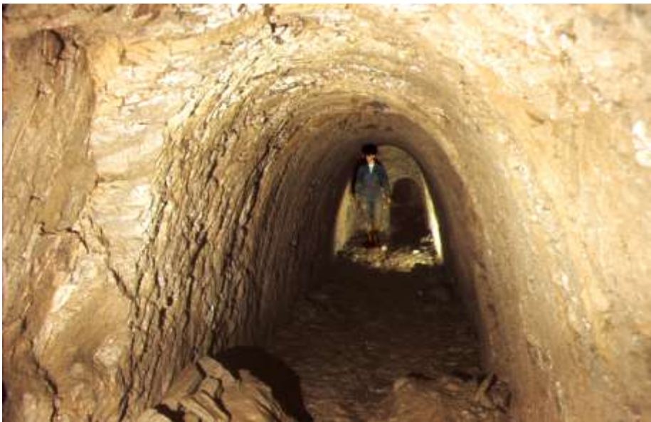
Fig. 2 : Galerie ouest du souterrain n°1 de Saint-Cirgues-de-Malbert
