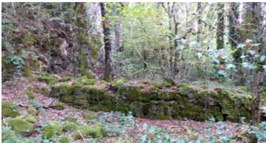
Fig. 9 : un des deux murets de l'esplanade en terrasse du pied de falaise de Civadal, Besse
