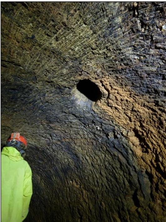
Fig. 13 : Conduit percé dans la voûte de la galerie - Montvert (Cliché : J.-P. Usse -2017).
