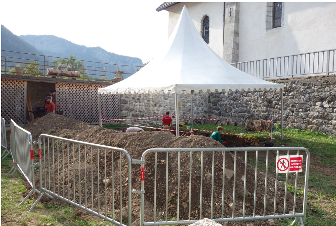
Fig. 17 - Sécurisation du chantier par des barrières et panneau «Chantier interdit au public».
