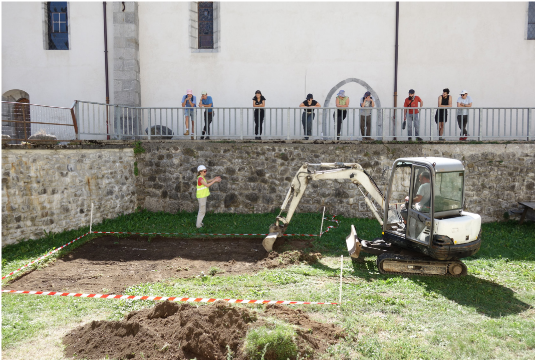
Fig. 16 - Ouverture du sondage à la pelle mécanique. © L. Donati.
