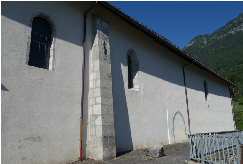
Fig. 9 - Mur gouttereau nord de l'église et porte médiévale condamnée au niveau de la nef des paroissiens.
