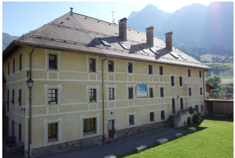
Fig. 10 - La façade sud de l'aile nord de l'ancien couvent.
