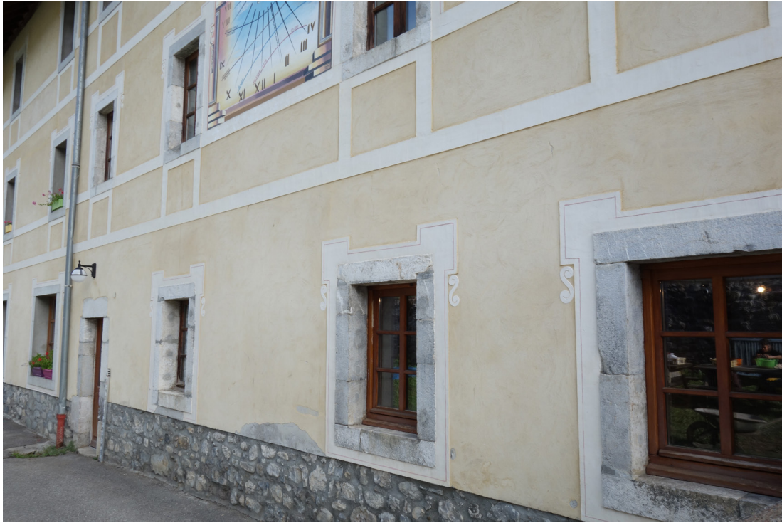
Fig. 30 - Fenêtres de la salle pédagogique du musée d'Entremont au rez-de-chaussée de l'aile nord du couvent (FEN 2005, et FEN 2006 – au premier-plan).
