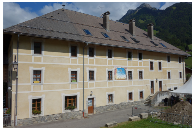
Aile nord du couvent vue depuis le sud-ouest.
