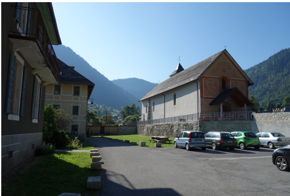
Fig. 7 - Site abbatial d'Entremont. À droite, l'église paroissiale (sud) et à gauche, l'aile nord du couvent. Entre les deux se trouve la parcelle n° 16.
