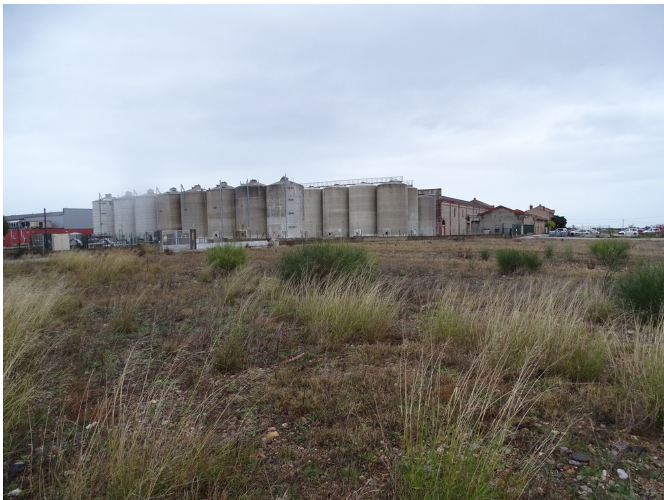
Fig. 13. Cave Arnaud de Villeneuve vue sur les cuves (source : Jean-Pierre Wolff)
