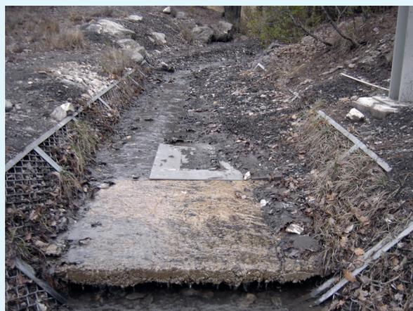
Vue sur le seuil en béton de calage du lit déployé en aval immédiat de la trappe à fente
