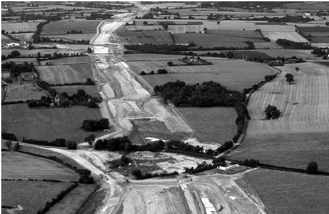
Fig. 1 – Vue aérienne du site des Chalaignes, sur le tracé de l'A87 (vue du nord, cliché: H. Paitier, Inrap).
