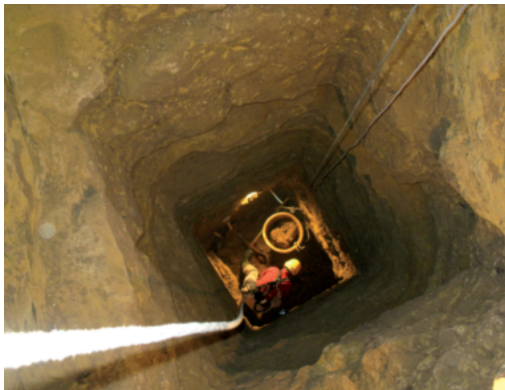
▼ Figure 20 : puits PT02 en cours de fouille. Cl. Équipe Inrap.
