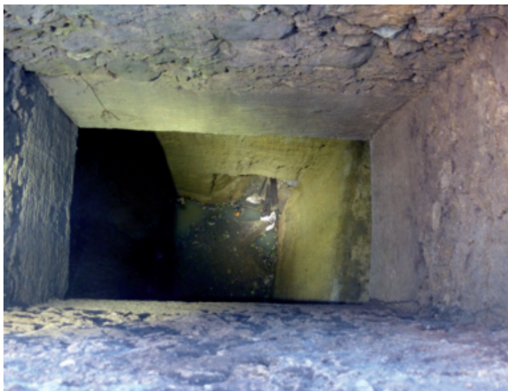
Figure 10 : la chambre de captage de la galerie moderne dite «galerie des Romains». cl. R. Haurillon.
