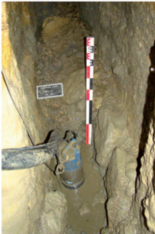
Fig. 4-4 : canalet au pied de la galerie souterraine
