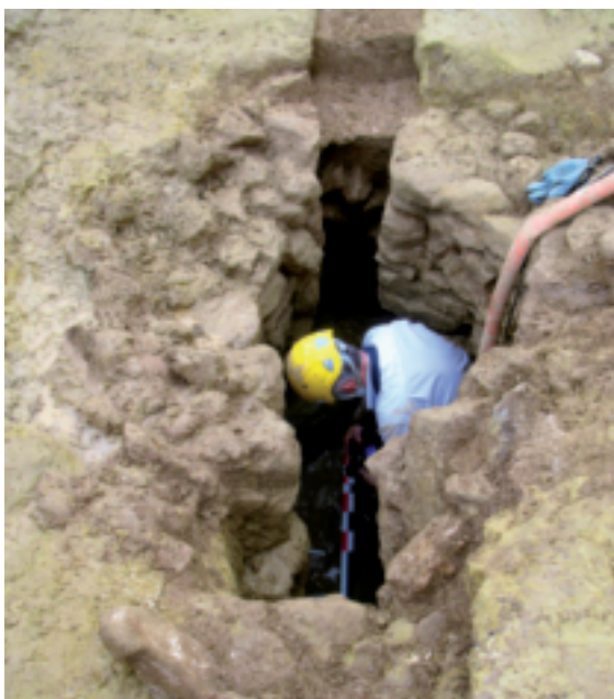
Figure 15 : puits PT1 du Garissou en fin de fouille. En arrière plan, la galerie souterraine écriquée. cl. Équipe Inrap.
