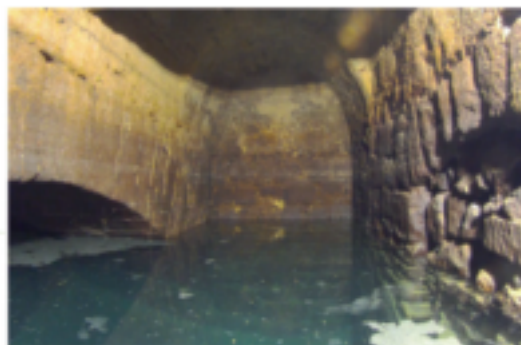
Fig. 6.2 : vue partielle de la citerne
