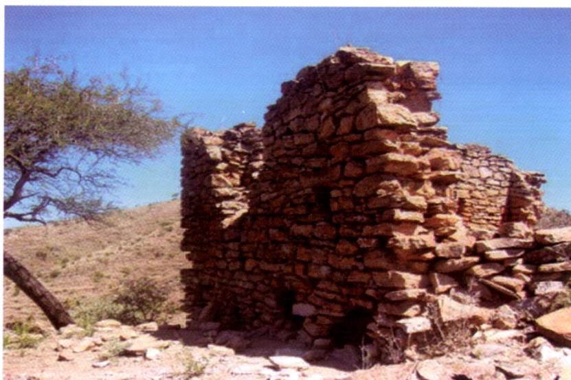
Photo 19 – Mosquée de Rassa Guba
