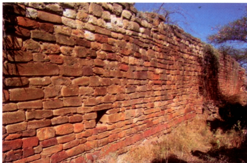
Photo 1 – Mosquée d'Asbäri : mur d'enceinte
