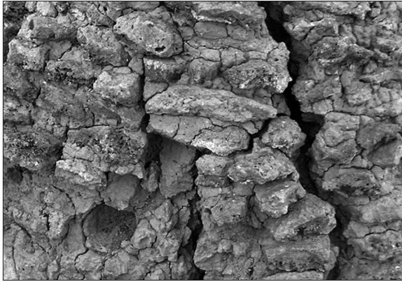
Fig. 35. Paroi externe construite à l'aide de scories de fond sableuses.
