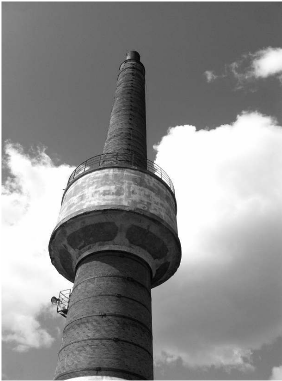
Figure 2 – La cheminée de la verrerie aujourd'hui
