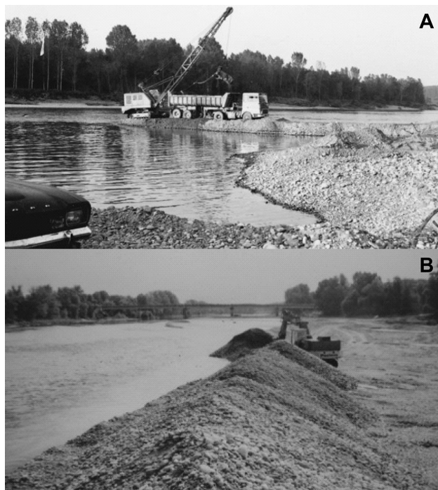
Fig. 2 – Extraction de granulats dans les années 1970 par fosse immergée à l'aide d'une dragline dans les environs de Mas-Grenier (a) et par décapage d'un atterrissement à l'aide d'une pelle mécanique à Ondes (b)
