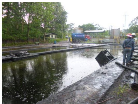
Figura 1. Balsa de acumulación de crudo.
