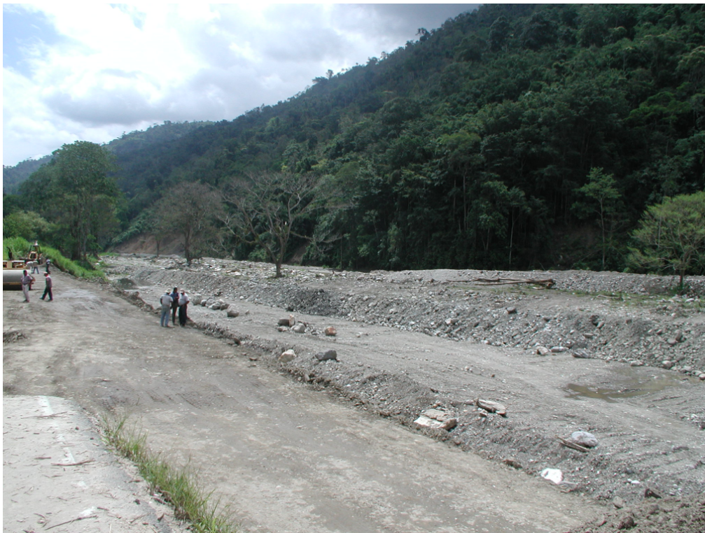
Photo 6d - Stock sédimentaire non stabilisé et non protégé sur les berges du Mocoties) à l'amont de Santa Cruz de Mora
