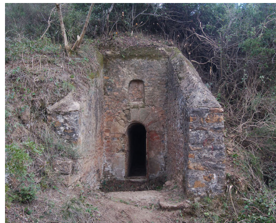
FIGURE 5 – Entrée amont du tunnel d'El-Habel
