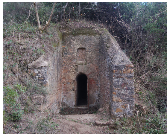
FIGURE 5 – Entrée amont du tunnel d'El-Habel
