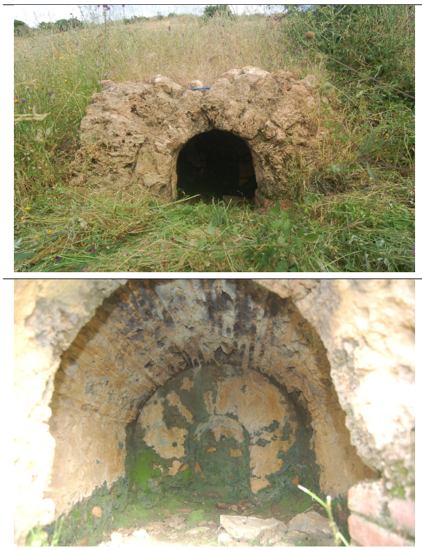
FIGURE 6 – Entrée du tunnel d'Ighil Imoula
