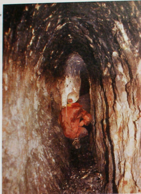
2. Les mineurs savent contrôler le gabarit d'ouvrage ouvert par le feu. Cette galerie du xvr e siècle présente la même largeur régulière que si elle avait été creusée à la pointerolle (mine Sanct Anna am Neuenberg, Sainte-Marie-aux-Mines).
